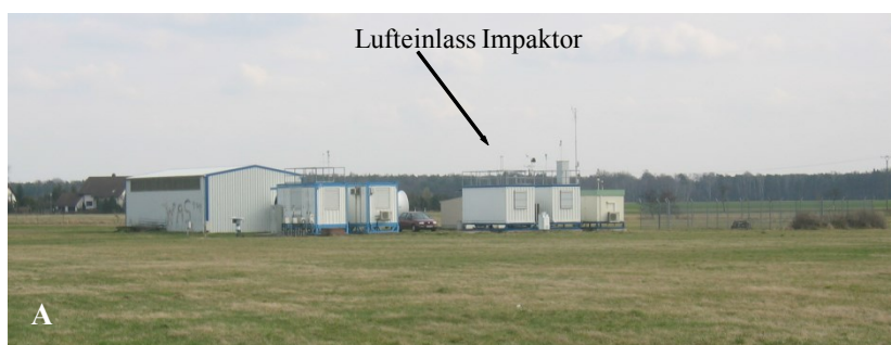
Abbildung 4: Forschungsstation Melpitz. A: Blick nach Südosten.
