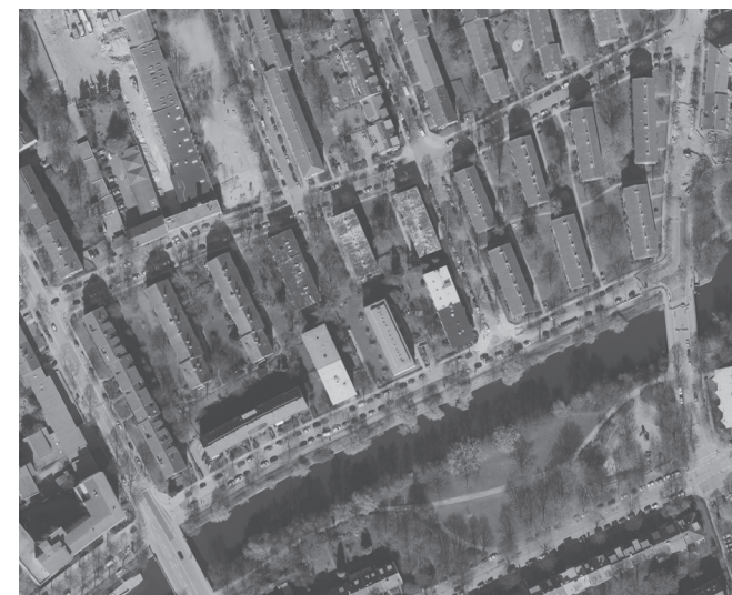
Abb. 97: Blick auf das untersuchte Areal einer Zeilenbebauung am Eilbekkanal
