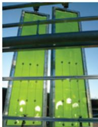
1) Bei diesem Gebäude werden Pflanzen zur Energiegewinnung genutzt. In den äußeren Glaselementen sind Bioreaktoren aus Algen integriert, die durch Photosynthese Energie produzieren.
