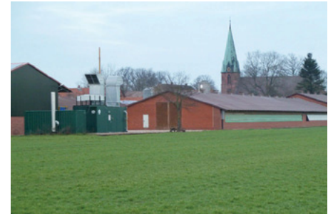
Biogas-BHKW und Putenstall
