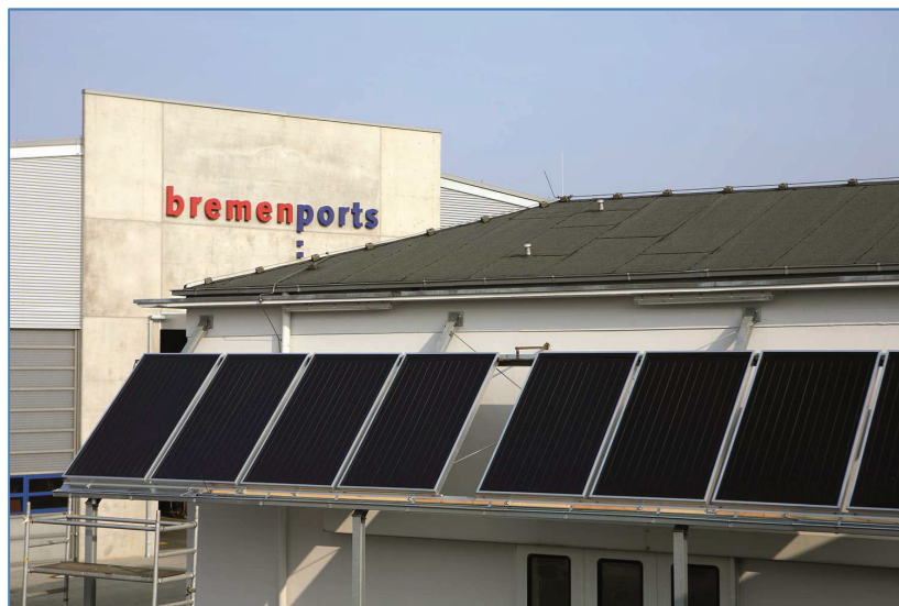
Abbildung 9: Photovoltaikanlage im Hafenbereich (Quelle: bremenports GmbH & Co. KG)
