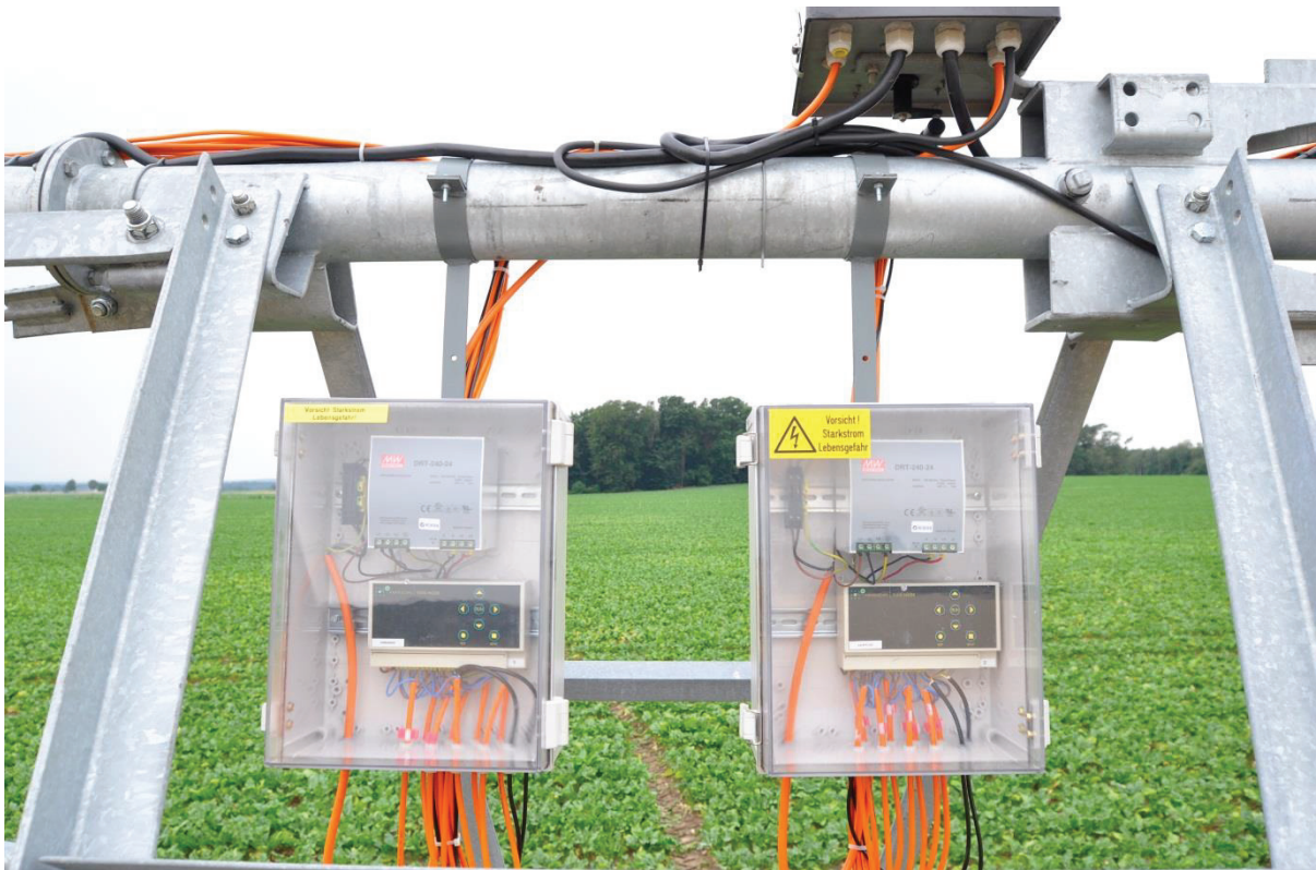
Abb. 10-7: Unterverteilung für die Magnetventile am Fahrturm
