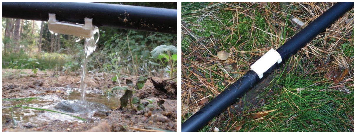
Abb. 3-6: Versickerungsdüsen mit Schutzkappe
