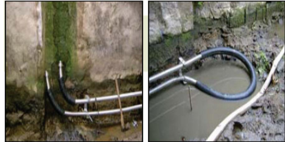
Fließwasserwärmetauscher FWT mit Umlenkeinrichtung
