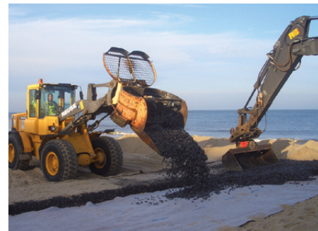
Ausbringen des Polyurethan-Schotter-Gemisches und Profilierung per Schaufelbagger (Foto: Treuel)
