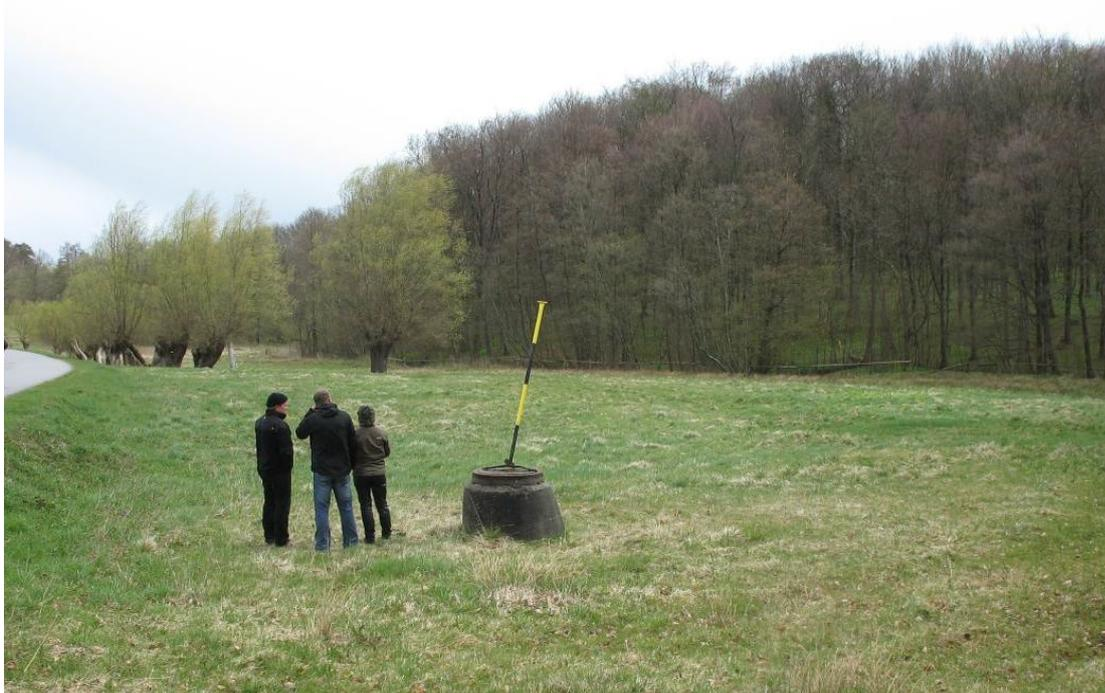
**Abbildung 3: Ausgewählter Standort für die Einrichtung eines dem Dränablauf (Schacht, im Vordergrund) nachgeschalteten Retentionsteiches vor dem Übertritt des Dränwassers in das Fließgewässer (Beeke, verläuft am Waldrand im Hintergrund) bei einem Ortstermin (Foto Steidl)**
